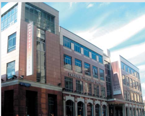
Офисно-торговый центр на Лесной ул., 3-9
